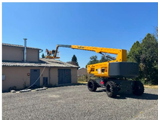
Nettoyage de la toiture salle des fêtes de Saint- Nauphary
