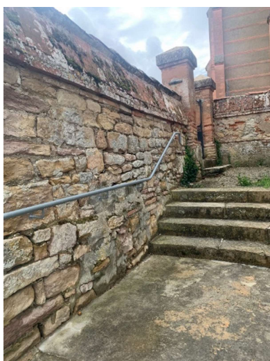
Rampe d'accès à l'église de Charros
