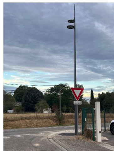
Modification lampadaire pour vidéoprotection angle Rte de Reynières/ZA Simarre
