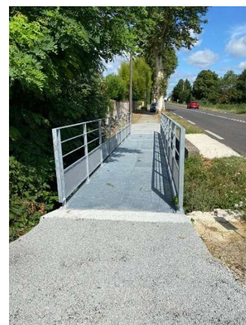
Passerelle route d'Albi
