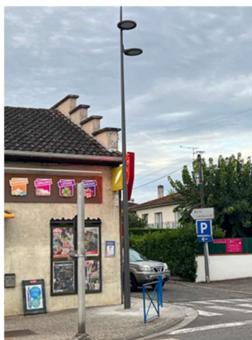
Modification lampadaire pour vidéoprotection Rte d'Albi
